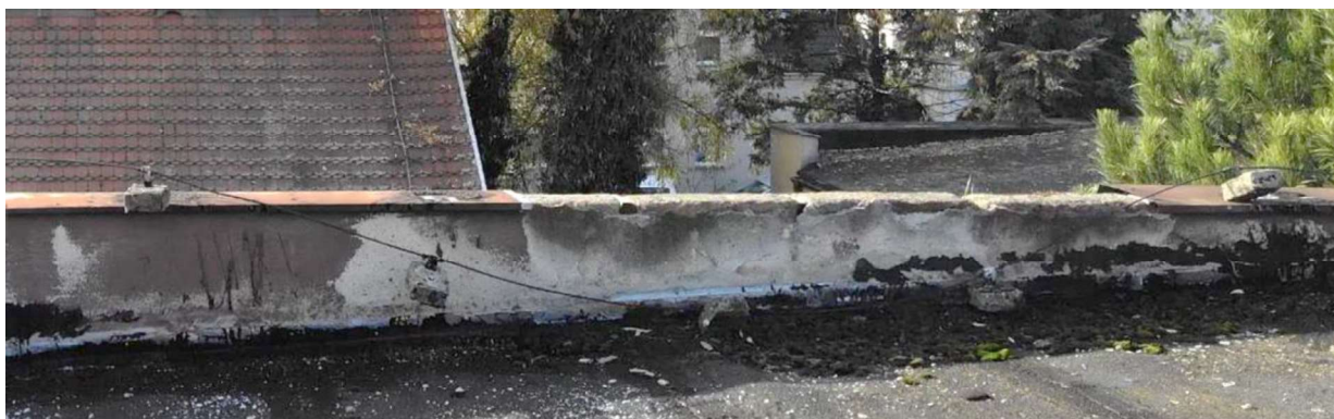
Stan attyk na dachu pawilonu wysokiego
