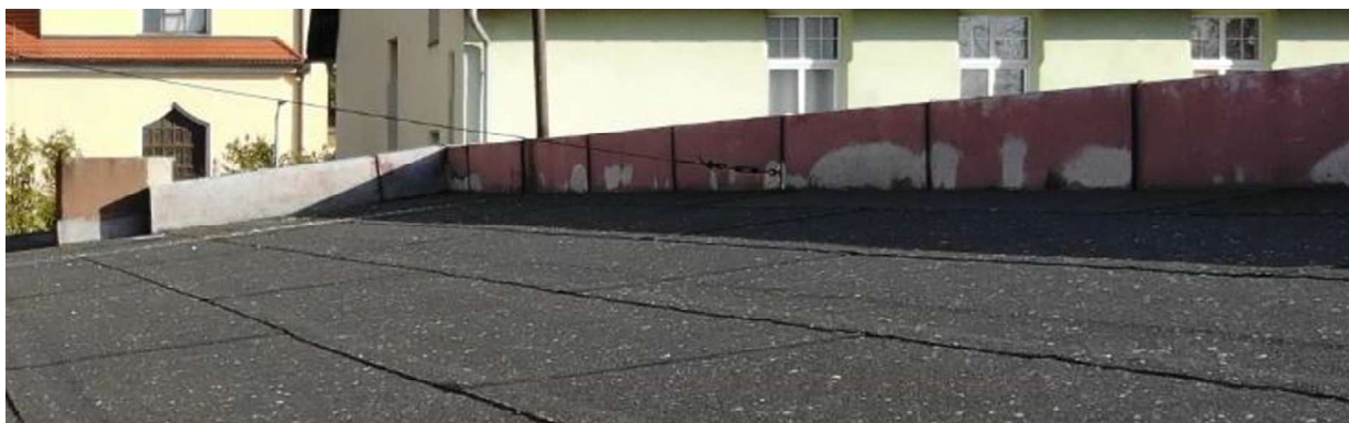
Stan attyk na dachu pawilonu niskiego – obróbka blacharska
