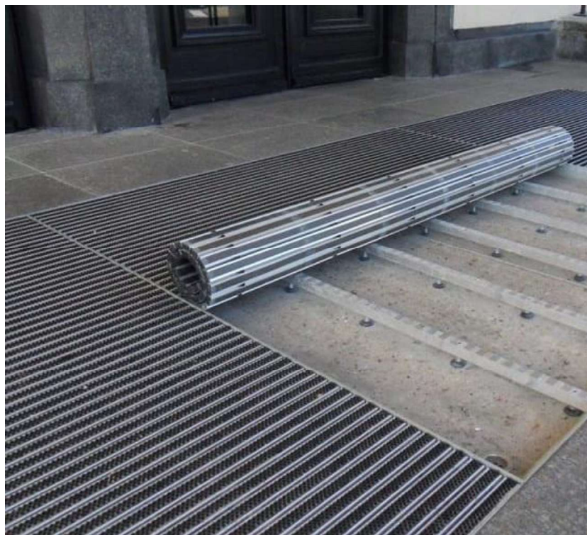
Przykład wycieraczki z osadnikiem z odpływem
